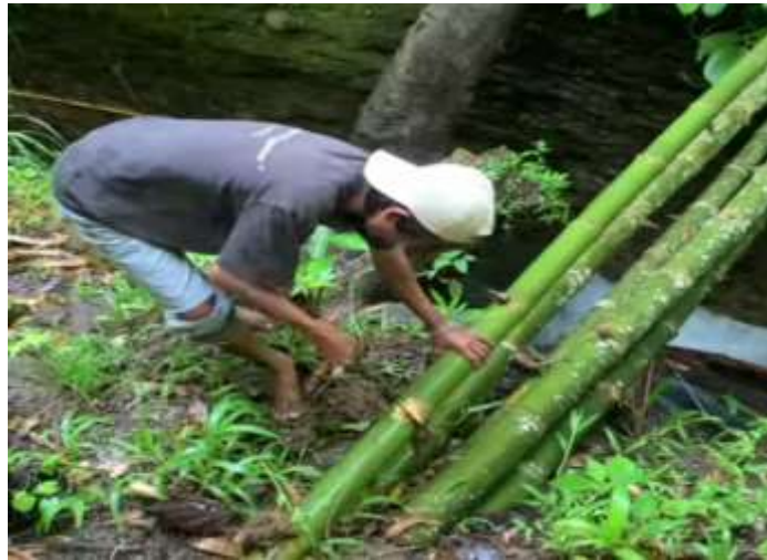
Gambar 5. Pembuatan jembatan menuju ke air terjun
