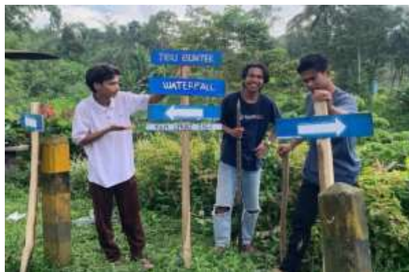
Gambar 7. Pemasangan papan penunjuk arah
