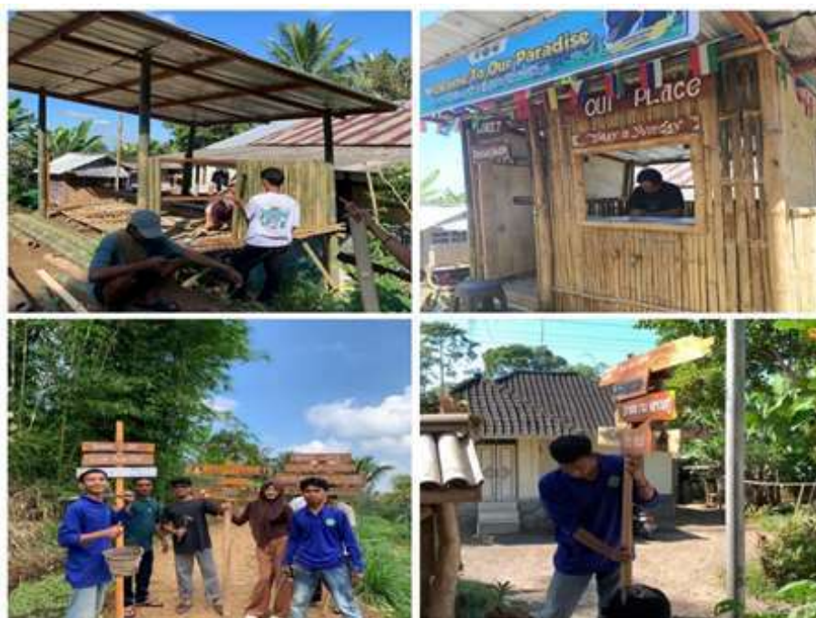
Gambar 2. Implementasi Sistem Single Gate melalui pembangunan loket masuk, pemasangan papan informasi, dan pemasangan papan penunjuk arah di Kawasan Wisata Durian Indah.
