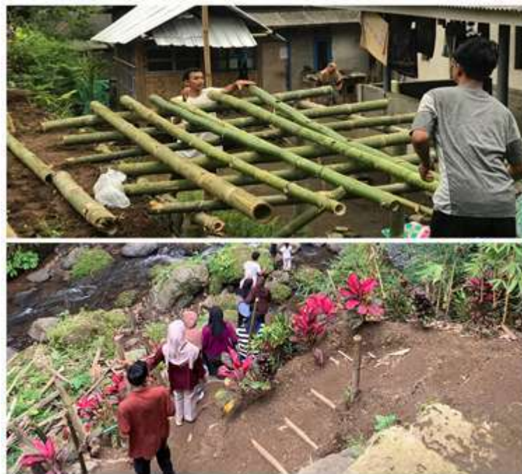
Gambar 1. Kondisi awal Kawasan Wisata Durian Indah sebelum implementasi Sistem Single Gate, menunjukkan belum tersedianya loket pelayanan, papan informasi, serta masih adanya beberapa jalur akses menuju kawasan wisata.
